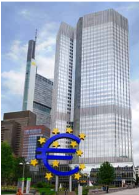
La Banque Centrale Européenne à Frankfort
